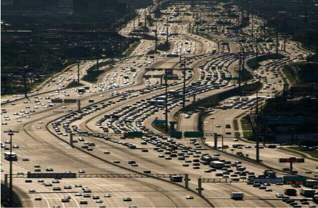
(Katy Freeway, Texas)
