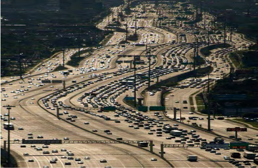
(Katy Freeway, Texas)
